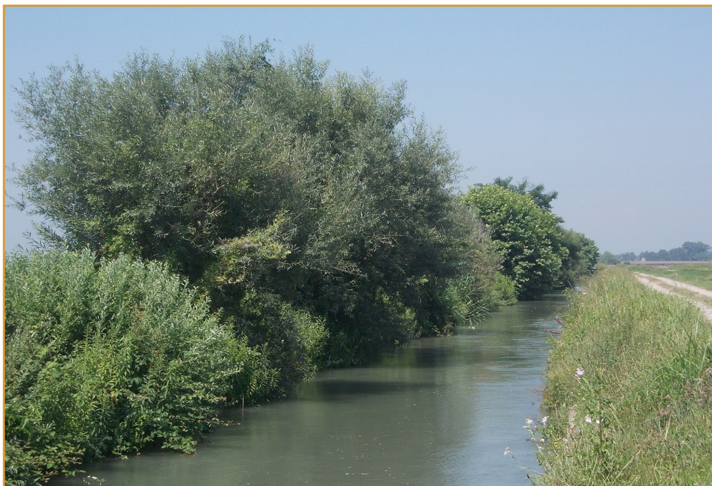
Figura 2. Intervento di sistemazione spondale sul Canale di Rive, realizzato nel 2005 e finanziato dal DOCUP 2000-2006, nell'ambito del PREL-Progetto Reti EcoLogiche. L'impiego di specie diverse piantate a gruppi, nel tempo diversifica il paesaggio (foto di R. Pagano).
